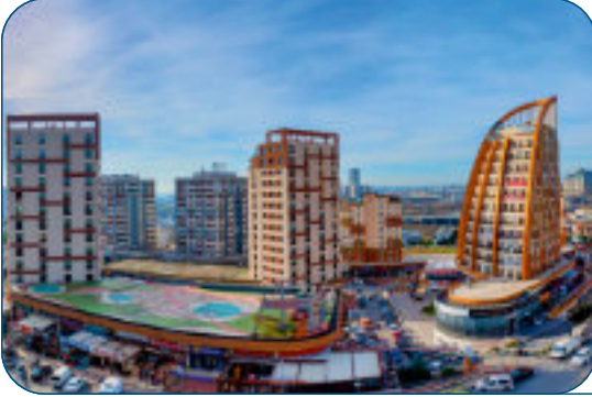
ARTERIUM 1. KISIM ELEKTRİK TESİSAT İŞLERİ 2011 BAŞAKŞEHİR / İSTANBUL
