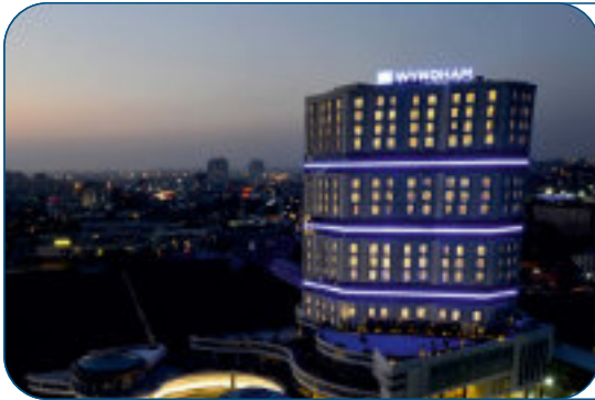
KILIÇBEY OTEL ELEKTRİK TESİSAT İŞLERİ 2013 GÜNEŞLİ/İSTANBUL
