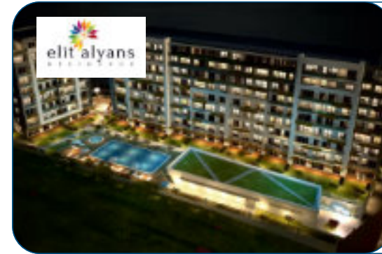
ELİT ALYANS RESIDENCE ELEKTRİK TESİSAT İŞLERİ 2014 ÇAYIROVA/KOCAELİ
