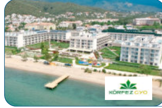
KÖRFEZ TATİL BELDESİ ELEKTRİK TESİSAT İŞLERİ 2016 EDREMIT/BALIKESİR
