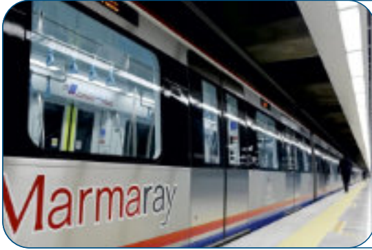
MARMARAY ELEKTRİK TESİSAT İŞLERİ 2013 ÜSKÜDAR/İSTANBUL
