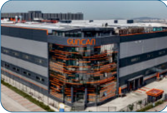
GÜNCAN PLASTİK FABRİKASI OG(2X2500KVA) VE AG ELEKTRİK TESİSAT İŞLERİ 2021 DİLOVASO İMES OSB.
