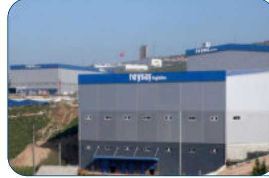
REYSAŞ GYO ÇAYIROVA DEPO 8 ELEKTRİK TESİSAT İŞLERİ 2014 ÇAYIROVA/KOCAELİ
