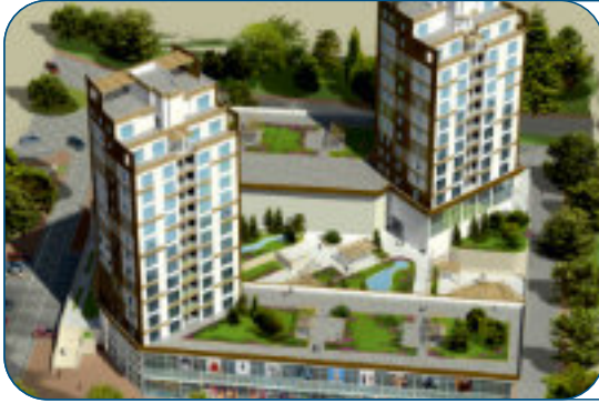
ARTERIUM PLUS ELEKTRİK TESİSAT İŞLERİ 2012 BAŞAKŞEHİR/İSTANBUL
