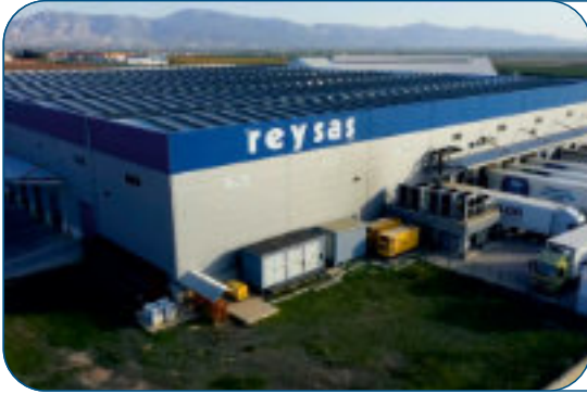
REYSAŞ GYO ESENYURT DEPO ELEKTRİK TESİSAT İŞLERİ 2017 ESENYURT/İSTANBUL
