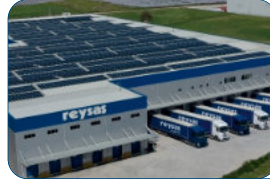
REYSAŞ GYO ADANA DEPO 4 OG VE AĞ ELEKTRİK TESİSAT İŞLERİ 2018 CEYHAN/ADANA
