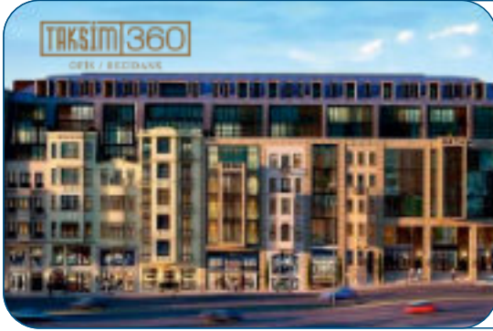
TAKSİM 360/387 KONUT&TİCARİ ELEKTRİK TESİSAT İŞLERİ 2022 TAKSİM/İSTANBUL
