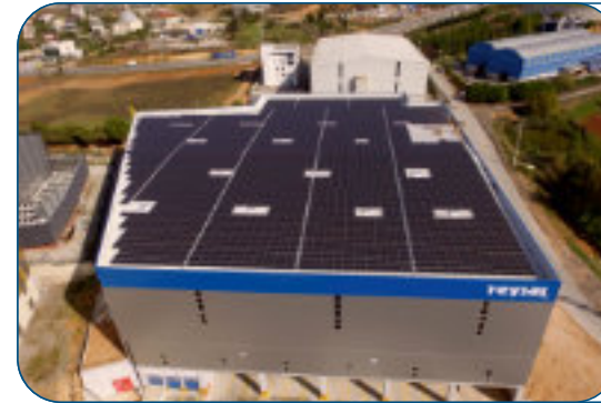
REYSAŞ GYO ANKARA SARAY DEPO 3 ELEKTRİK TESİSAT İŞLERİ 2016 KAZAN/ANKARA
