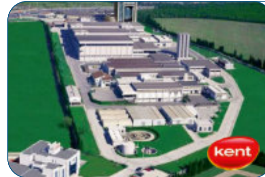
KENT GIDA ELEKTRİK TESİSAT İŞLERİ 2009 ÇAYIROVA / KOCAELİ
