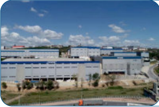
REYSAŞ GYO ORHANLI DEPO 6 ELEKTRİK TESİSAT İŞLERİ 2019 ÇAYIROVA/KOCAELİ
