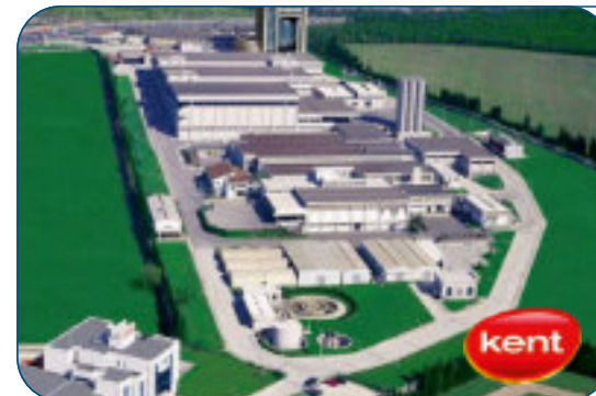
KENT GIDA ELEKTRİK TESİSAT İŞLERİ 2017 ÇAYIROVA/KOCAELİ
