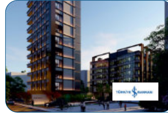
İŞ BANKASI MUNZAM SANDIK VAKFI ELEKTRİK TESİSAT İŞLERİ 2020 ERENKÖY/İSTANBUL
