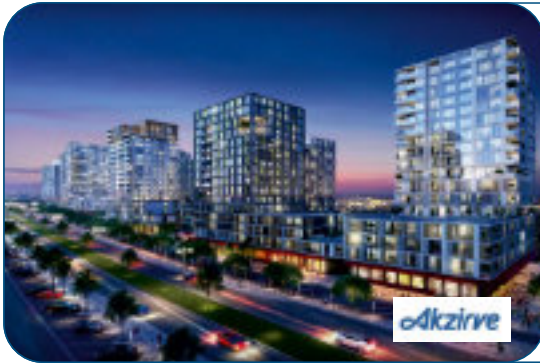
AKZİRVE SATIŞ OFİSİ ELEKTRİK TESİSAT İŞLERİ 2016 BEHÇEŞEHİR/İSTANBUL
