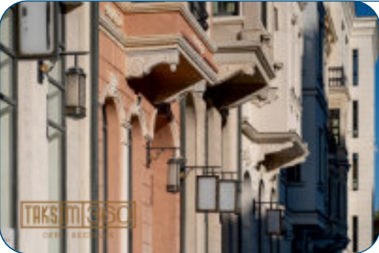
TAKSİM 360/385-386 KONUT & TİCARİ ELEKTRİK TESİSAT İŞLERİ 2019 TAKSİM/İSTANBUL
