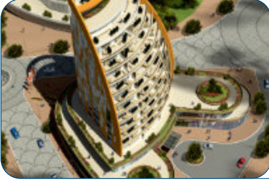
ARTERIUM 4. KISIM ELEKTRİK TESİSAT İŞLERİ 2014 BAŞAKŞEHİR/İSTANBUL
