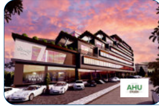
GÖKÇE İNŞAAT VE İNŞAAT MALZEMELERİ SAN.TİC.A.Ş. ELEKTRİK TESİSAT İŞLERİ 2017 ÇAYIROVA/KOCAELİ
