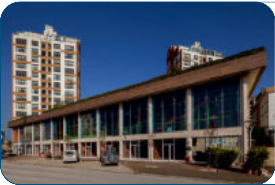
ARTERIUM 2. KISIM ELEKTRİK TESİSAT İŞLERİ 2012 BAŞAKŞEHİR/İSTANBUL
