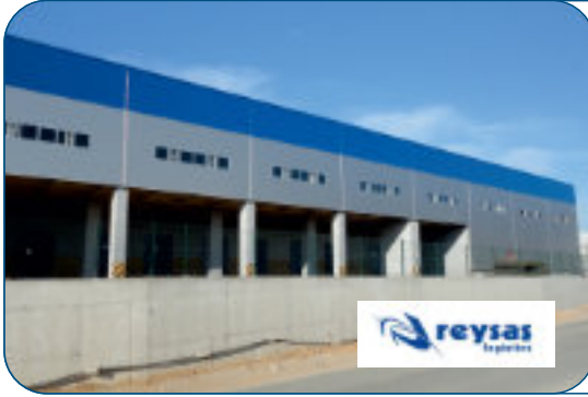
REYSAŞ GYO ORHANLI DEPO 5 OG VE AG ELEKTRİK TESİSAT İŞLERİ 2016 TUZLA/İSTANBUL
