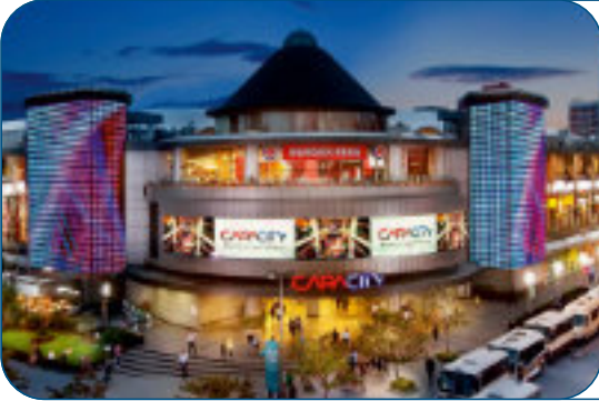
CAPACITY AVM ELEKTRİK TESİSAT İŞLERİ 2007 BAKIRKÖY/İSTANBUL
