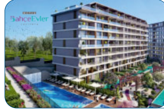
MOPAŞ BAHÇEEVLER ÇAYIROVA OG VE AG ELEKTRİK TESİSAT İŞLERİ 2019 ÇAYIROVA/KOCAELİ
