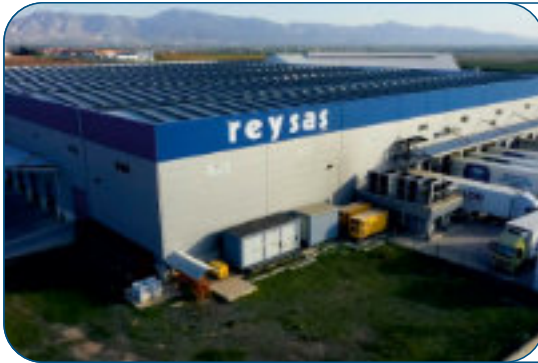
REYSAŞ GYO ÇAYIROVA DEPO 9 ELEKTRİK TESİSAT İŞLERİ 2016 ÇAYIROVA/KOCAELİ
