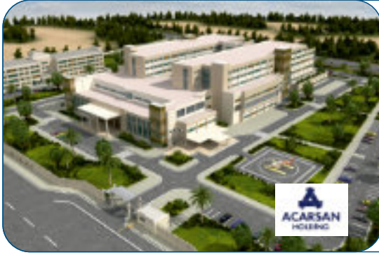
ACARSAN İNŞAAT A.Ş. ELEKTRİK TESİSAT İŞLERİ 2015 EL AMARA/IRAK
