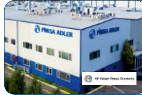
HP PELZER PİMSA FABRİKA ELEKTRİK TESİSAT İŞLERİ 2013 ŞEKERPINAR/KOCAELİ
