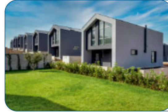
VİLLA OLEA TEPEÖREN ELEKTRİK TESİSAT İŞLERİ 2022 TEPEÖREN/İSTANBUL
