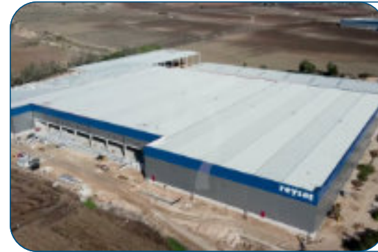
REYSAŞ GYO ADANA SULUCA DEPO 3 ELEKTRİK TESİSAT İŞLERİ 2016 CEYHAN/ADANA
