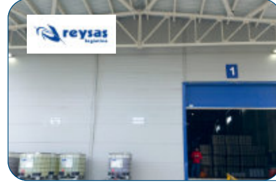
REYSAS GYO ÇAYIROVA DEPO 10 OG VE AG ELEKTRİK TESİSAT İŞLERİ 2015 ÇAYIROVA/KOCAELİ
