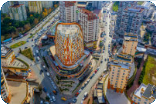
ARTERIUM 5. KISIM ELEKTRİK TESİSAT İŞLERİ 2014 BAŞAKŞEHİR/İSTANBUL
